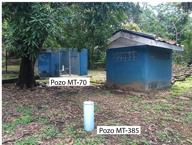
Fotografía 9: Vista de los dos pozos ubicados dentro del lote de Vigía. En la parte superior izquierda se muestra el pozo MT-70
