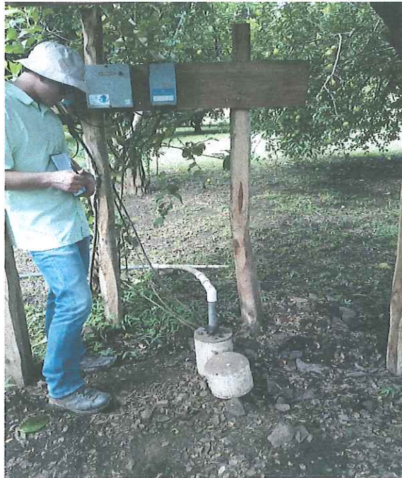
Fotografía 15: Pozo 7 Coordenadas 434357 E/238619 N, nivel estático en 20,72 m.b.n.s.
