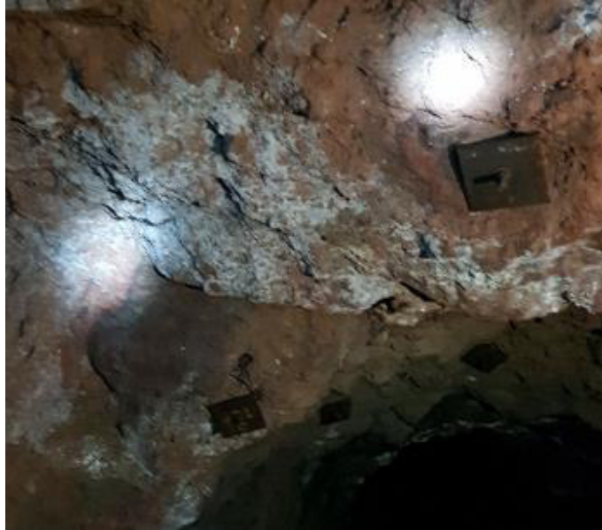
Fotografía N° 4 Pernos puntuales en corona de túnel 3.
