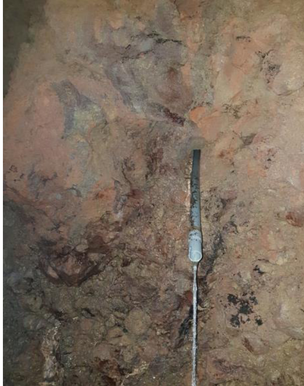
Fotografía N° 7 Sector de afluencia leve de agua en túnel 3 contacto entre brecha lávica y autobrecha.
