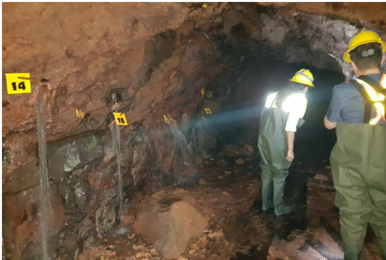
Fotografía N° 9 Sector de afluencia alta de agua en túnel 3 en contacto entre colada de lava fracturada y autobrecha.
