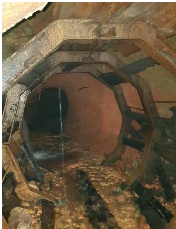
Fotografía N° 5 Tramo de arcos de acero en túnel 1.
