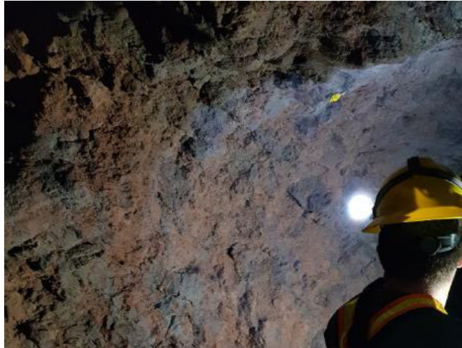
Fotografía N° 2 Autobrecha conformada por bloques volcánicos en matriz limo-arcillosa de color rojiza-morada en túnel 3
