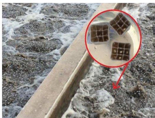
Figura 7. Sistema IFAS con biosoportres móviles de polietileno (“carriers”) en la PTAR El Roble.
