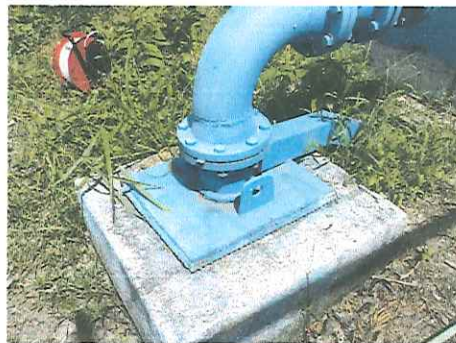
Foto 12: Pozo AyA 5 Baltodano
