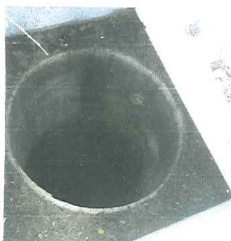
Foto 13: Pozo excavado seco
