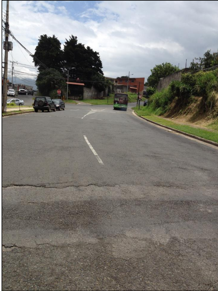
Figura 4.1 Calle Donde se Instalará Tubería
