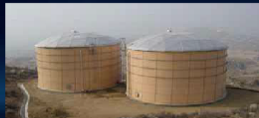
▲ Instalaciones de tanques múltiples de Almacenamiento Plástico.
