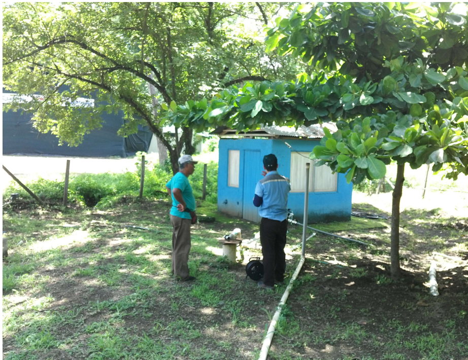
Foto 2. Pozo 2. Coordenadas: 355588 E/ 218259 N
