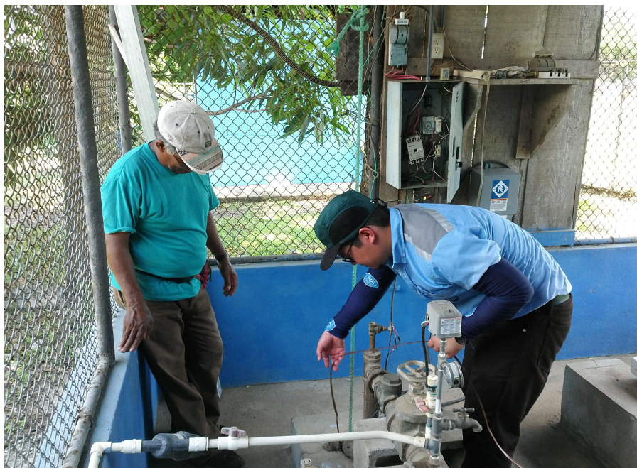
Foto 1. Pozo 1. Coordenadas: 355341 E/218548 N
