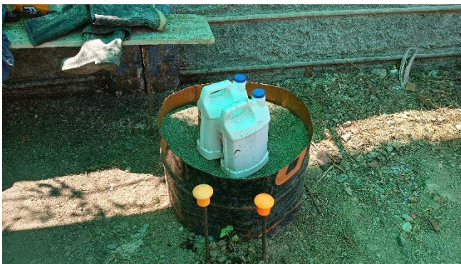
Pichingas con thinner colocadas dentro de recipiente para derrames.
