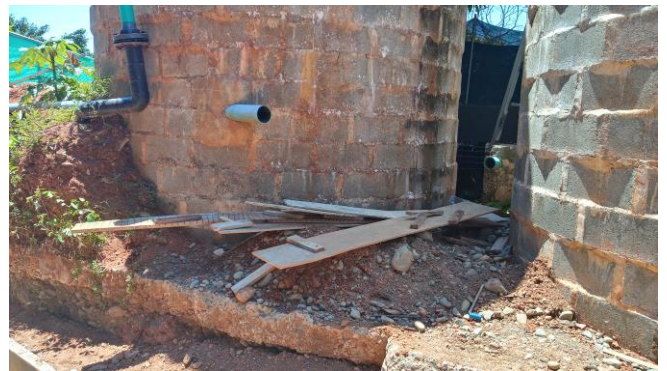
Acopio de madera de desecho temporal que se retira al final del día.
