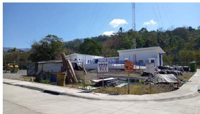
Área de almacenamiento de materiales.
