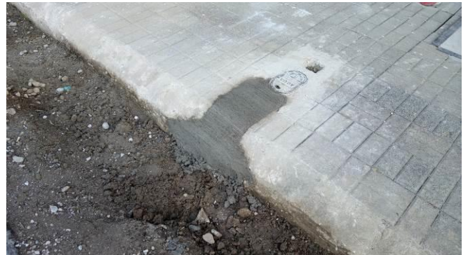
Reparaciones en acera.
