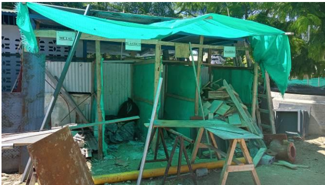
Estado actual del centro de acopio.
