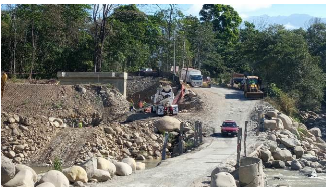
Obras constructivas por parte del MOPT en Puente Río General.
