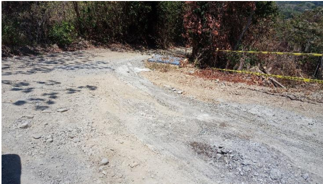
Sector fuera del AP en donde se lavaron las chompias de la chorrea de la fundación.
