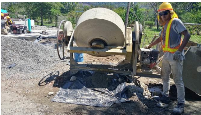
Colocación de película de plástico debajo de la batidora.
