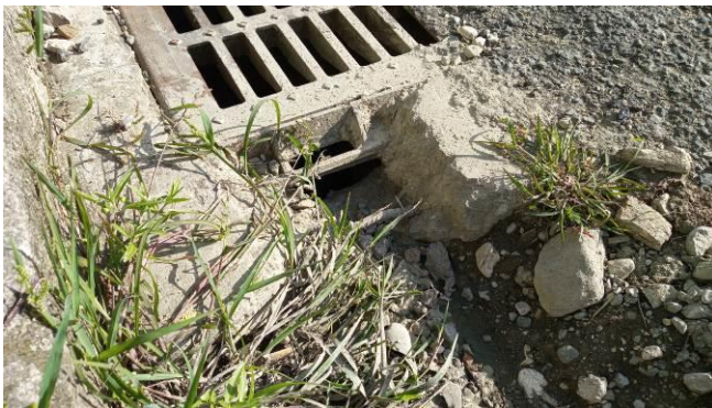
Abertura en tragante pluvial que permite el paso de sedimentos.
