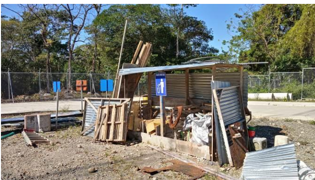
Estado actual del centro de acopio.
