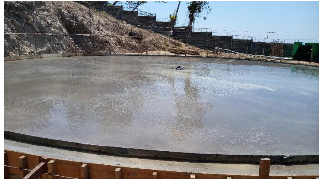
Espejo de agua sobre la losa.
