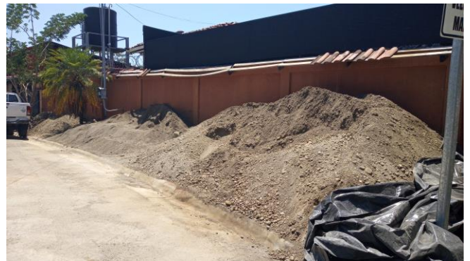
Acopio de material en vía pública que debe cubrirse con plástico.
