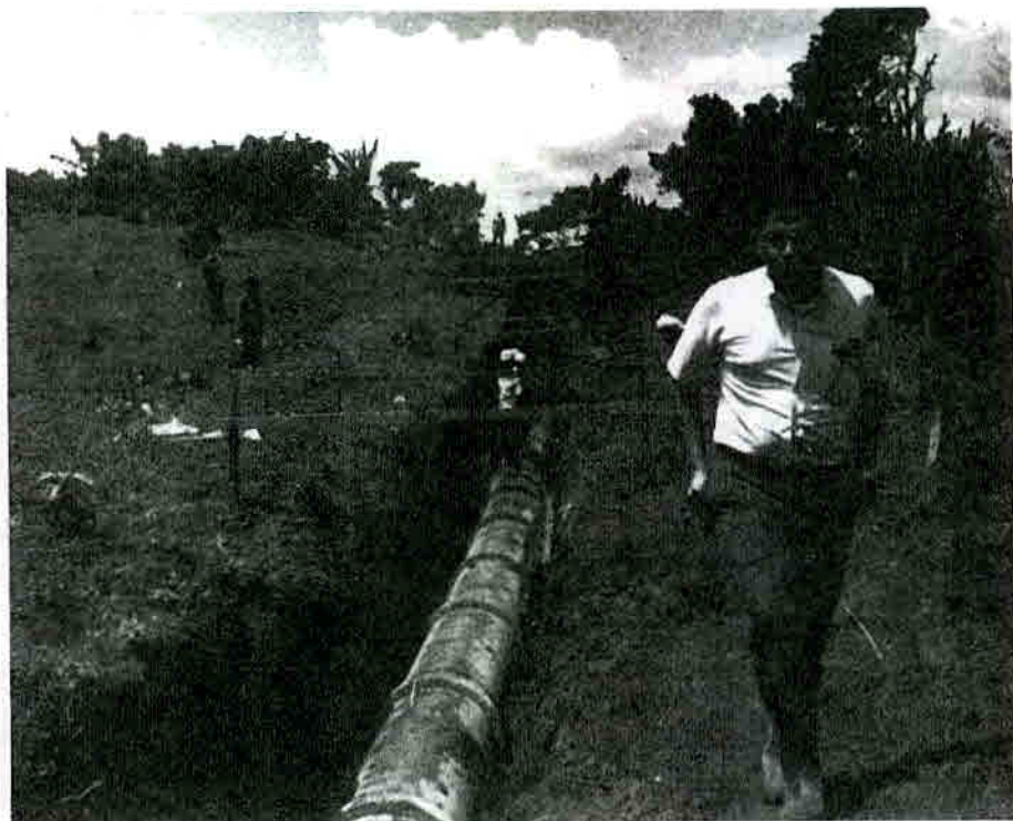
Tubería de concreto ya colocada en la nueva conducción a la planta de Los Sitios de Moravia.
