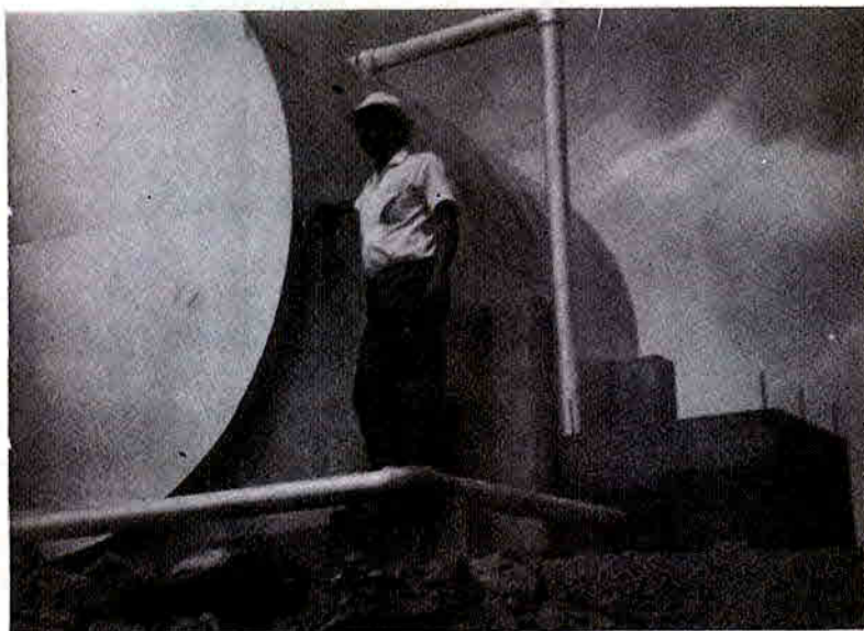
Tanque metálico de almacenamiento, colocado horizontalmente, de 22 mil litros de capacidad del nuevo acueducto para Bolsón y Ortega de Santa Cruz de Guanacaste.
