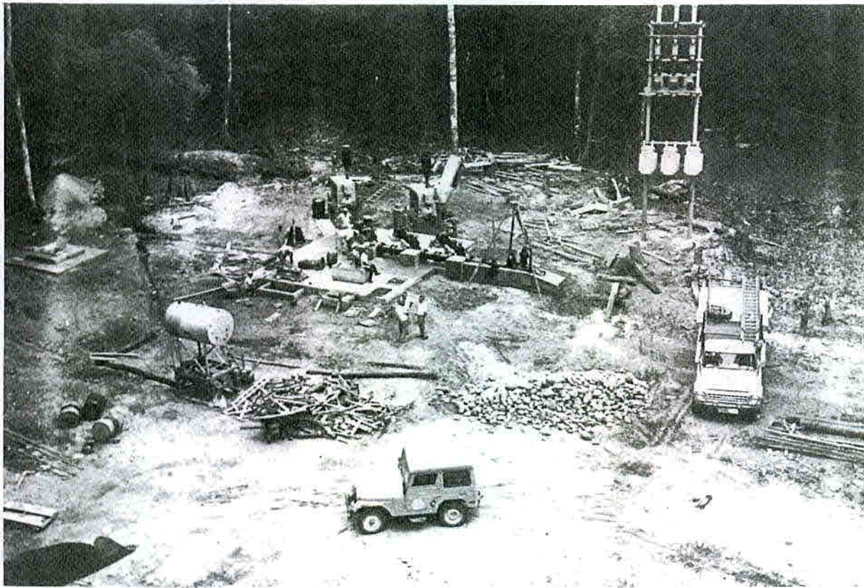
Vista general de las obras en construcción en las fuentes de Moín.
