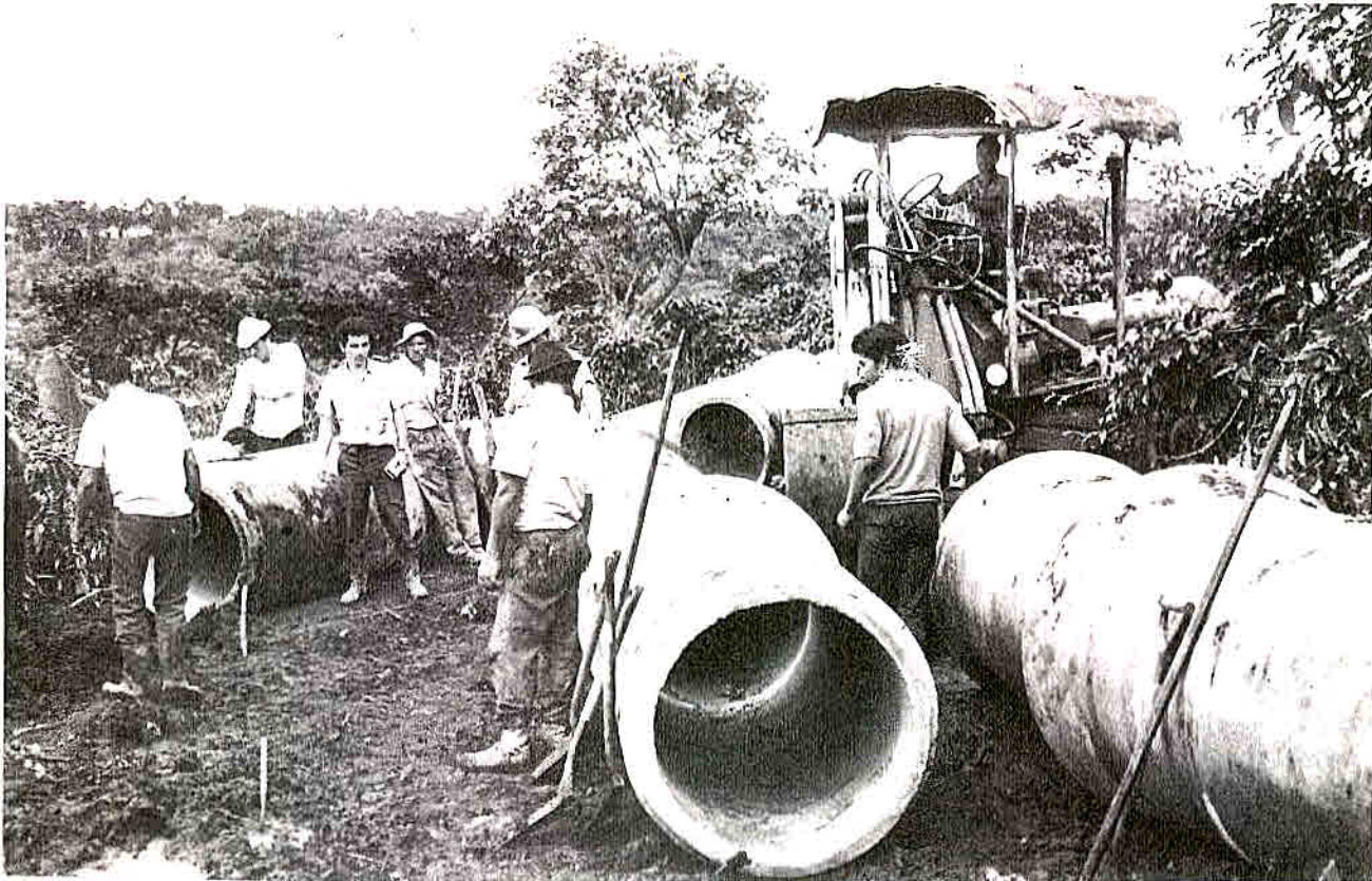
Transporte de los tubos de concreto reforzado, de 2.5 m. de longitud y 30 pulgadas de diámetro, para colocar en el
