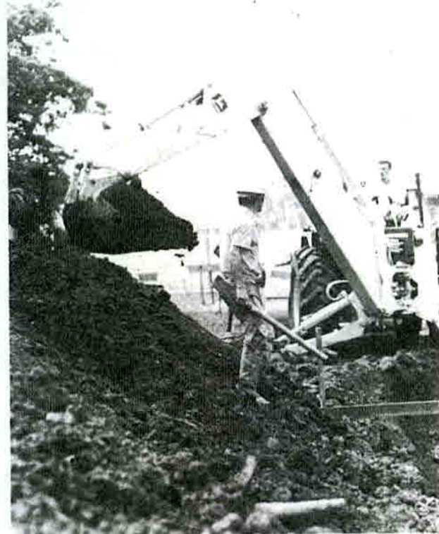
Moderna máquina retroexcavadora abre las zanjas en el sector de Pavas.
