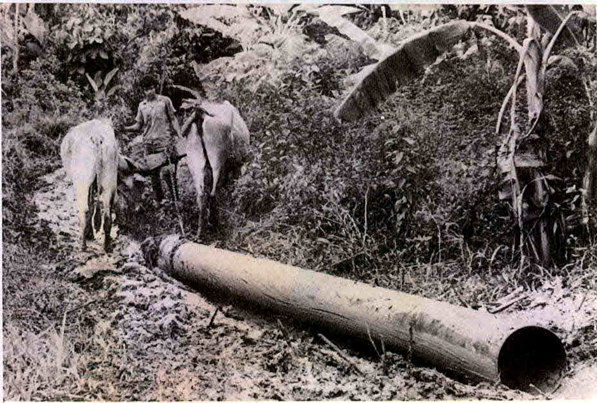
Dadas las condiciones difícilísimas del terreno por la humedad constante, los tubos de 12 pulgadas para la conducción del agua de Moín a Limón, tuvieron que ser transportados con yuntas de bueyes.
