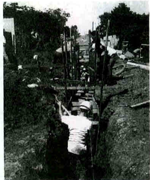
Nuevo alcantarillado sanitario para el área metropolitana. Trabajadores de la empresa Construcciones, Conducciones y Pavimentos, abren la zanja, en el centro de Pavas, donde será colocada tubería de concreto en diámetros de 8, 6 y 4 pulgadas.
