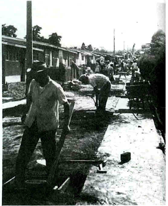
Trabajos de colocación de medidores en la ciudadela Rodrigo Facio.
