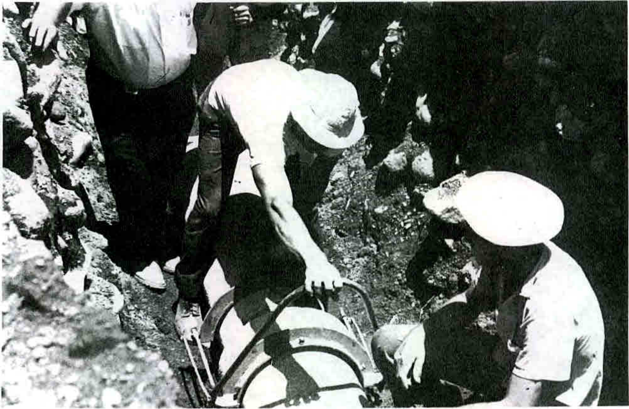
Acoplamiento de dos tubos de la red colectora del Alcantarillado sanitario para San Isidro de El General.
