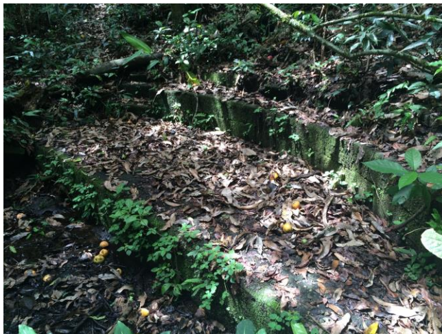
Fotografía 5: Captación abandonada El Cedral (Coordenadas 500406- 204074 Lambert Norte)
