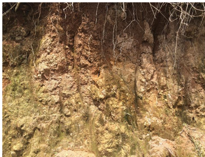
Fotografía 8: Materiales meteorizados Grifo Alto (coordenadas 499778– 203999 Lambert Norte)
