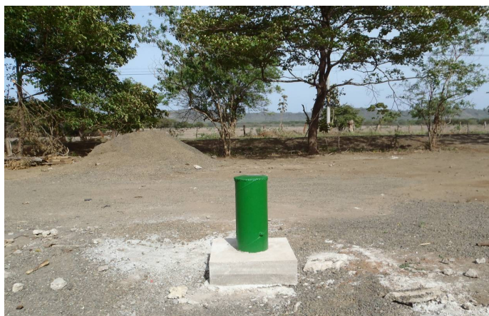
Fotografía 3. Pozo CN-725 (Trancas N° 1) 361846 E – 285850 N. Margen este de carretera, vista al norte-este.
