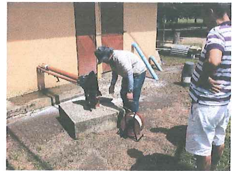
Foto 1: Pozo ASADA Brasilito 1
