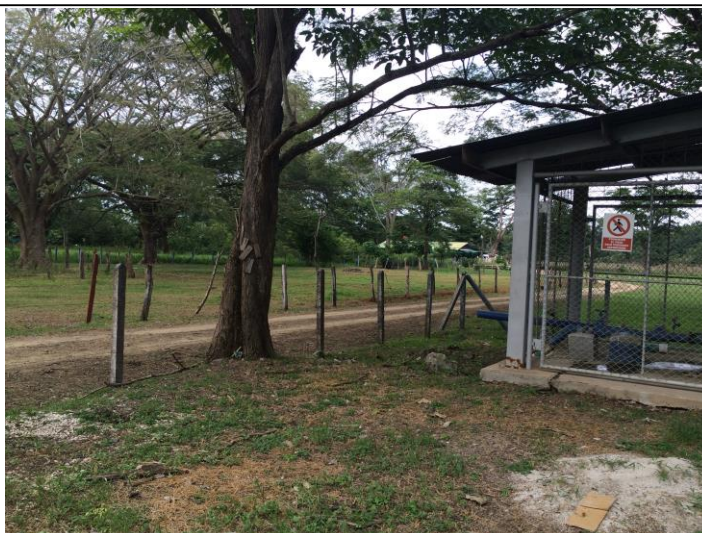
Fotografía 5: Estado actual pozo Portegolpe 1 (BE-482), (coordenadas 346623– 258753 Lambert Norte)
