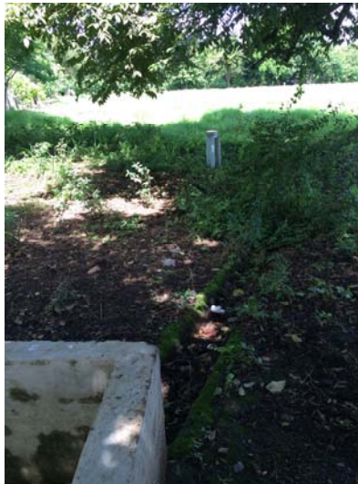
Fotografía 4: Estado actual pozo Canjelito (coordenadas 407238 - 220162, Lambert Norte)
