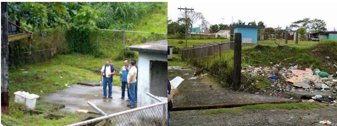
Fotografía 4.6. Estación Pacuare 2 y obstrucciones del sistema pluvial por basuras
