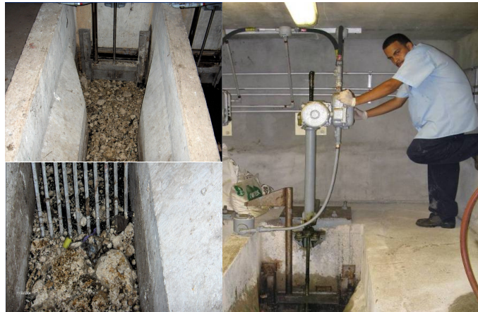
Fotografía 4.20 Personal de la EPA removiendo la gran cantidad de grasa que ingresa
