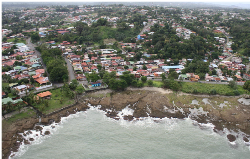
Fotografía 4.3. Se muestra en la costa la Estación de Aguas Residuales Asis Esna.
