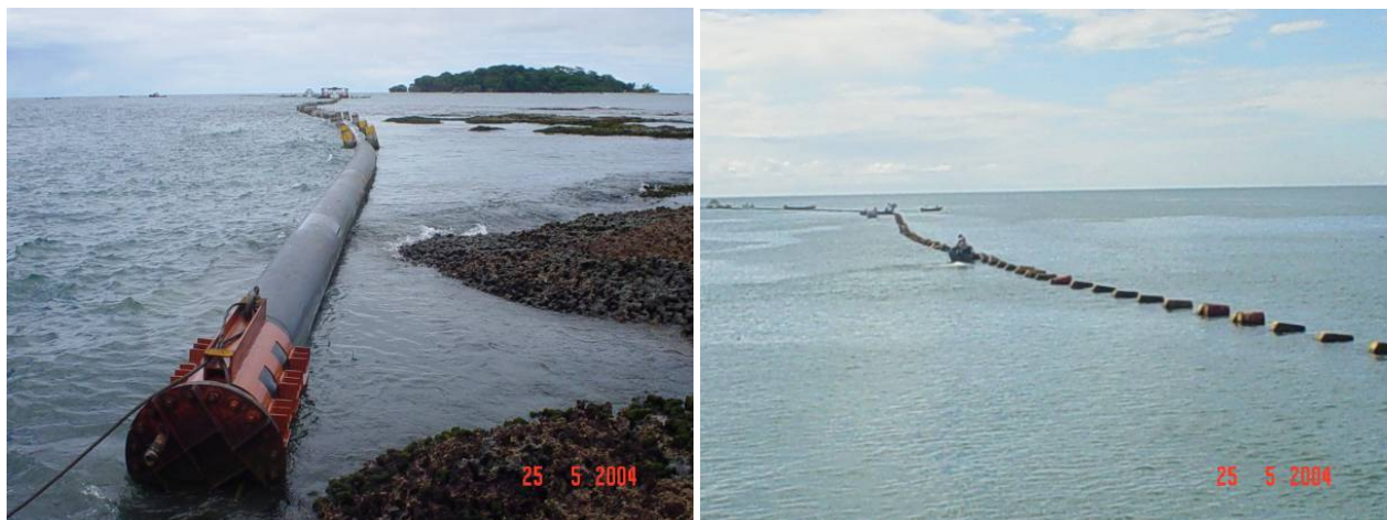
Fotografía 4.14 Fase de Instalación de la tubería del Emisario Submarino
