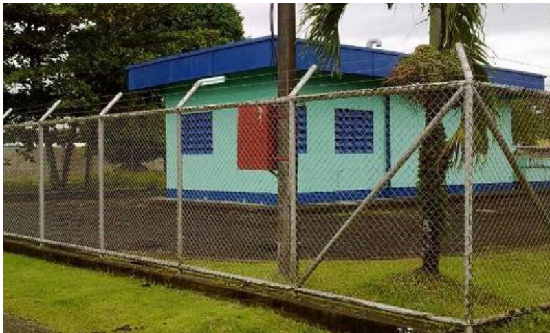
Fotografía 4.4. Estación de Aguas Residuales Cristóbal Colón.
