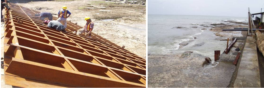
Fotografía 4.18. Pantalla de protección frente a la EPA
