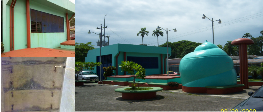
Fotografía 4.7 Edificación donde esta albergada la EPA.
