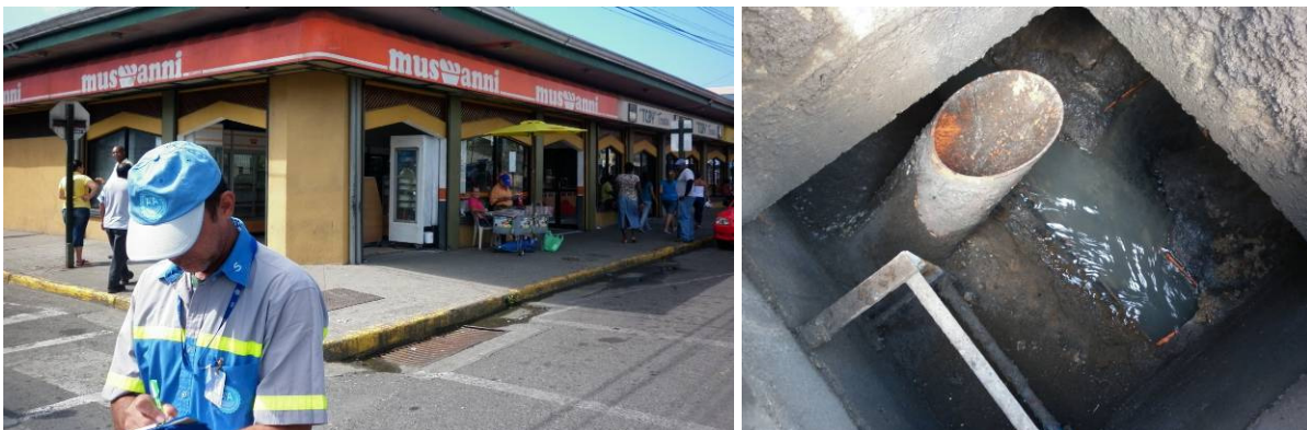
Fotografía 5.2 Interconexión entre los sistemas de alcantarillado sanitario y alcantarillado pluvial
