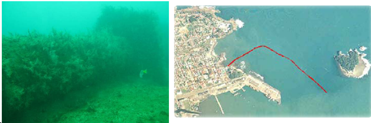
Figura 4.15. Tubería del emisario colocada en el fondo marino y trayectoria
