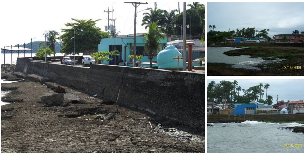
Fotografía 4.17. Vista desde el mar del muro de protección contra oleajes
