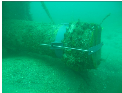
Fotografía 4.15. Válvula de cierre con herraje de sujeción
