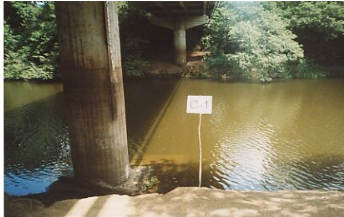
FOTO 14 Punto C-1: Belén, Carrillo, bajo puente de río Cañas
