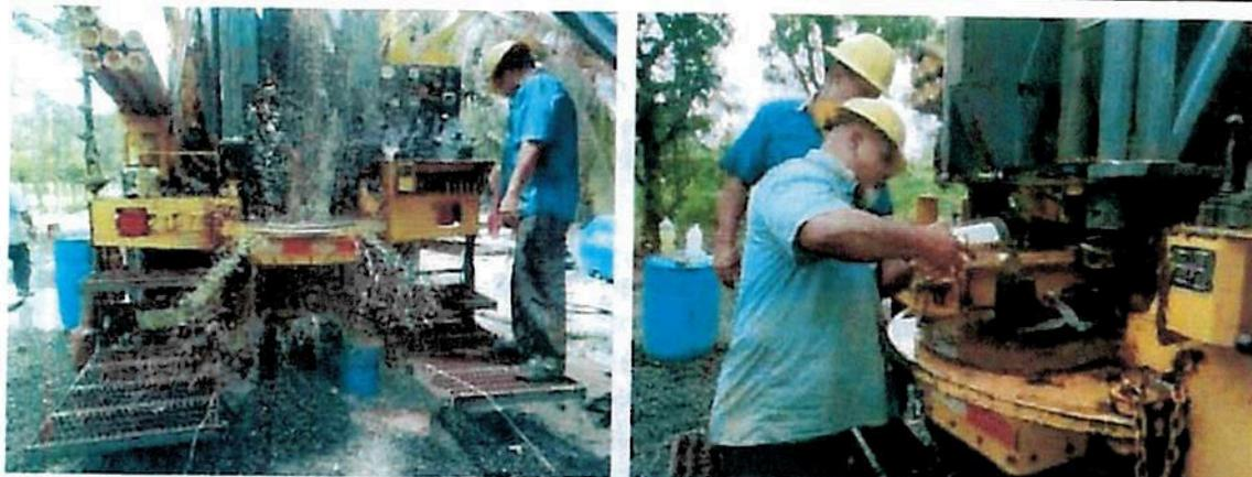
Fotografías 7-8: A la izquierda se muestra el proceso de desarrollo por medio de la inyección de aire comprimido, a la derecha la aplicación del producto químico para la desintegración de la bentonita.
