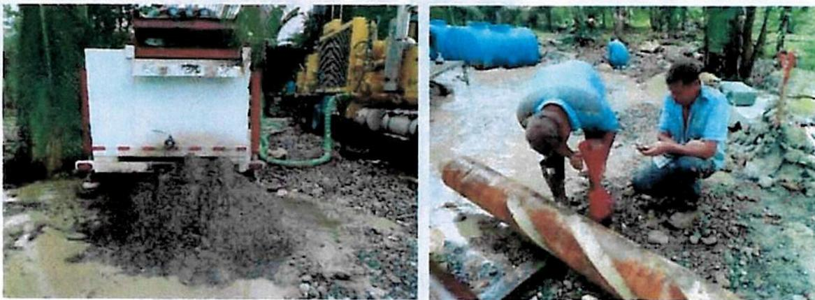
*Fotografías 5-6: A la izquierda se muestra el equipo de lodos trasladado para evacuar los detritos producto de la perforación, a la derecha se observa el monitoreo del fluido de perforación a partir de la medición de la viscosidad.*
