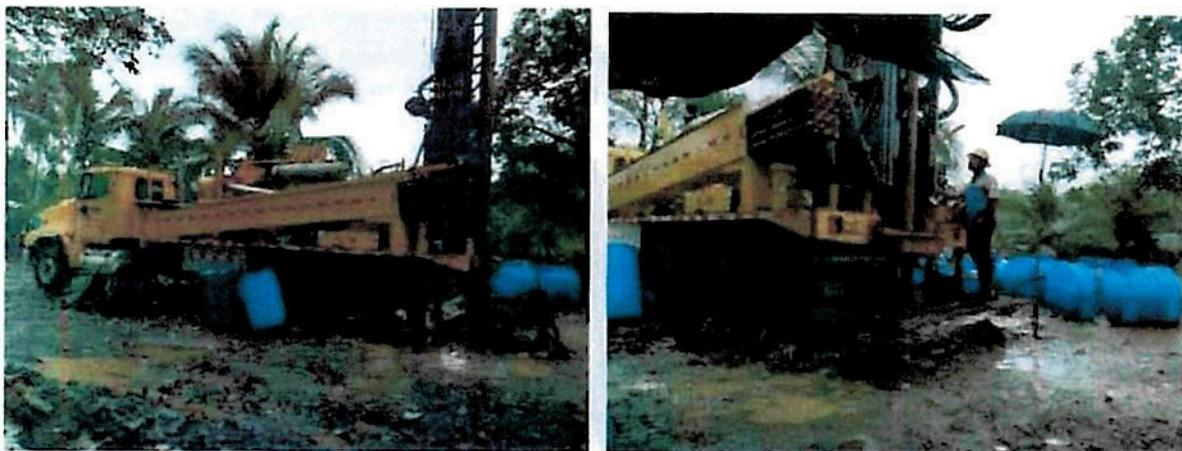
*Fotografías 3-4: A la izquierda se muestra el posicionamiento de los equipos de perforación dentro del área de trabajo, a la derecha la máquina perforadora T3W n°4 utilizada durante la perforación del pozo 19-06.*
