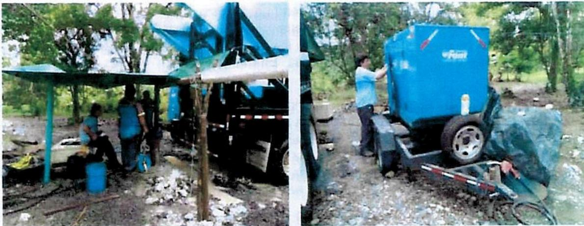
Fotografías 9-10: A la izquierda se muestra la instalación del equipo de bombeo sumergible, a la derecha la planta eléctrica trasladada para la ejecución de la prueba de bombeo.
