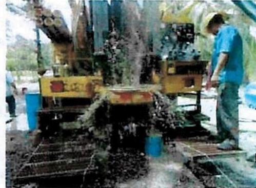
Labores de desarrollo del pozo por medio de la inyección de aire en la sección ranurada.
