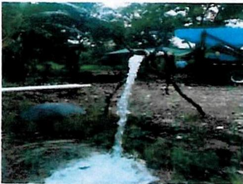
Prueba de bombeo ejecutada por la UTP por espacio de 72 horas. Caudal de prueba 12 L/s.
