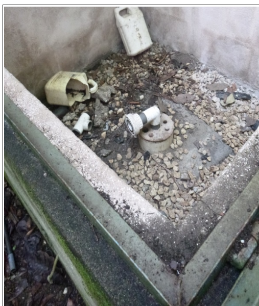
Fotografía 6. Pozo P-5 (Coordenadas: 212 038 N y 431 530 E)
