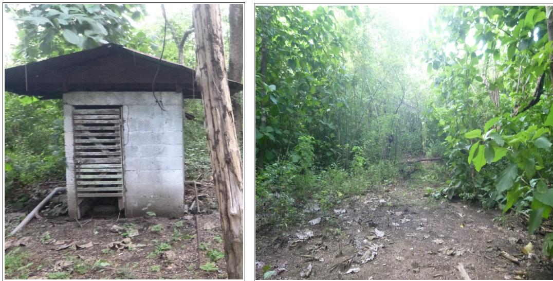
Fotografía 1. Pozo P-1 (P-59), localizado en el lote propuesto por la ASADA para la perforación de un nuevo pozo. (Coordenadas: 213 415 N y 429 828 E)
