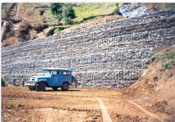
Reforzamiento del Proyecto Orosi
