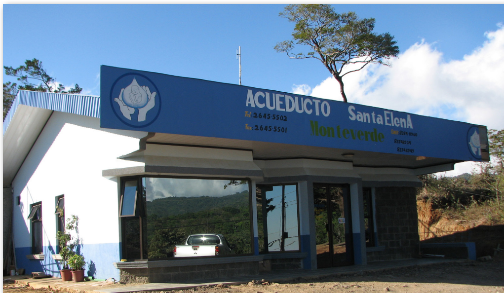
Acueducto rural, Monteverde.
