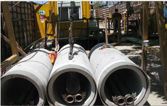
Tuberías para construcción de colectores
