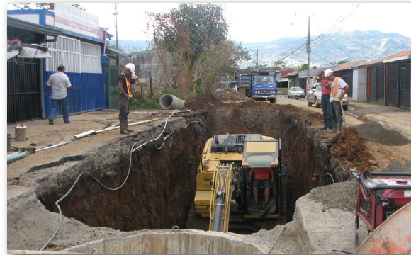
Construcción de Colectores
