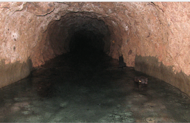
Túneles de Puentes de Mulas, Belén de Heredia.
