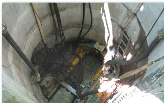
Colector de Aguas Residuales en proceso de construcción
