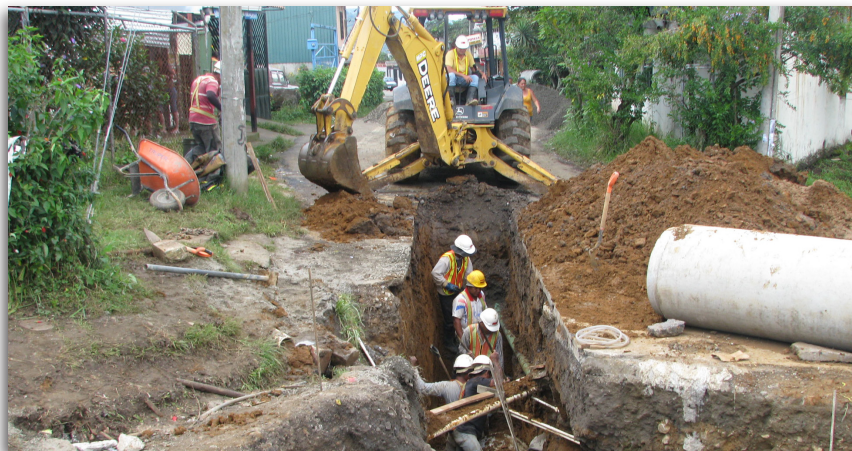
Proeso de instalación de tuberías
