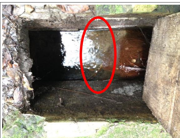
Fotografías 17. Raíces en captación naciente Javier Paniagua. Coordenadas E 503629 m y N 231159 m, Costa Rica Lambert Norte.
